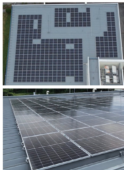
図3 IC 工場の太陽光パネルの設置
