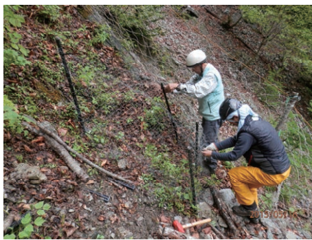
二ホンジカによる食害を防ぐ柵の設置
