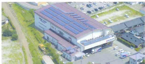
本社屋根上に設置した太陽光発電・太陽熱給湯システム
