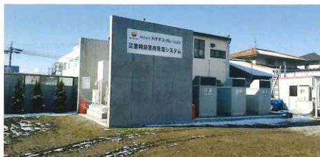
災害時非常用電源システム
